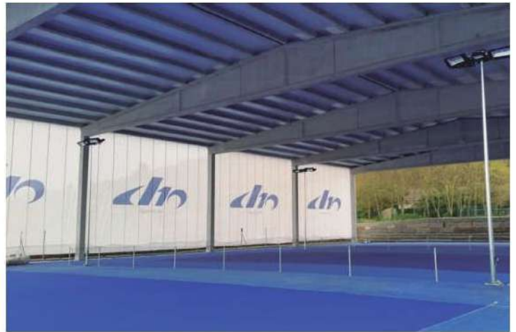
CUBIERTAS EN PREFABRICADO DE HORMIGÓN
